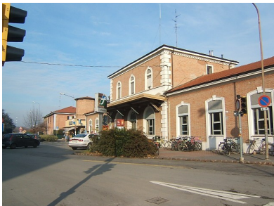
Stazione ferroviaria di Carpi
